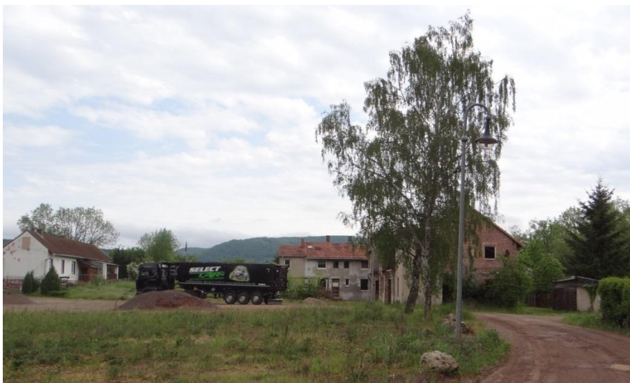
Bauliche Brache der ehemaligen Wohnnutzung Eberthof, Foto 2016
