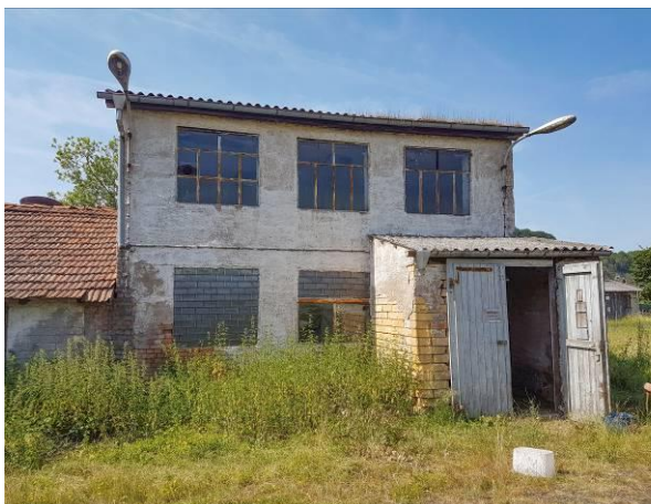
Abb. 4: Außenansicht des Schafstalls
