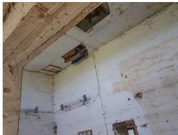
Abb. 5: Innenansicht des Schafstalls mit potentiellen Habitaten für Vögel, oder Fledermäuse
