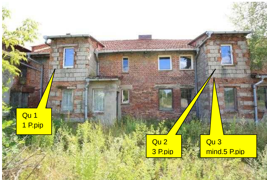
Abb. 10: Fledermausquartiere an der Nordwestfassade
