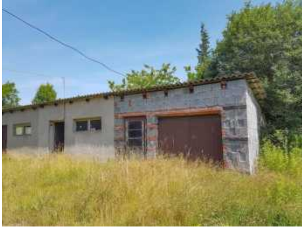
Abb. 8: Garagenreihe nordöstlich des Abrissgebäudes)
