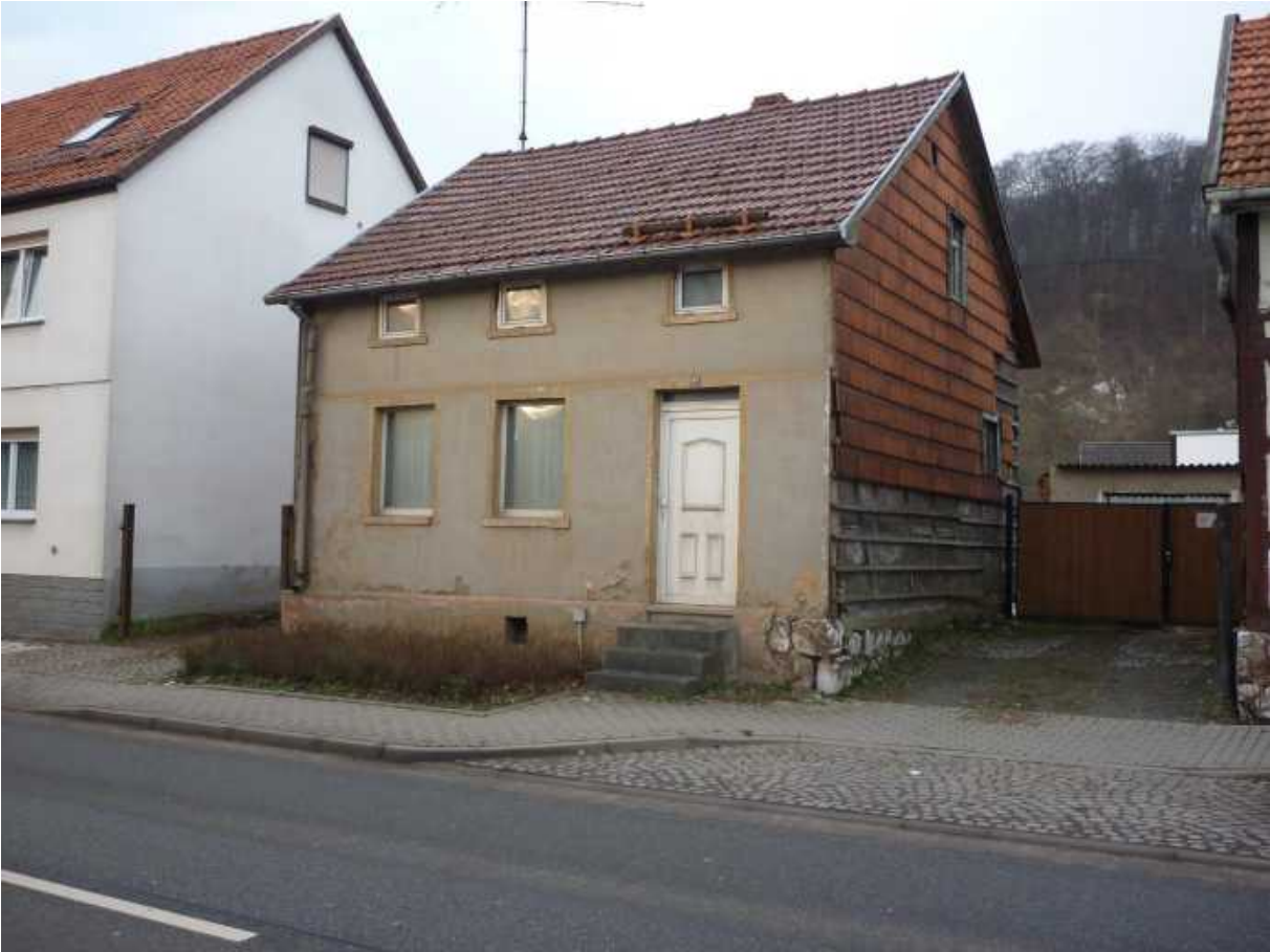
Nr. 10 – Ilfelder Straße 22
