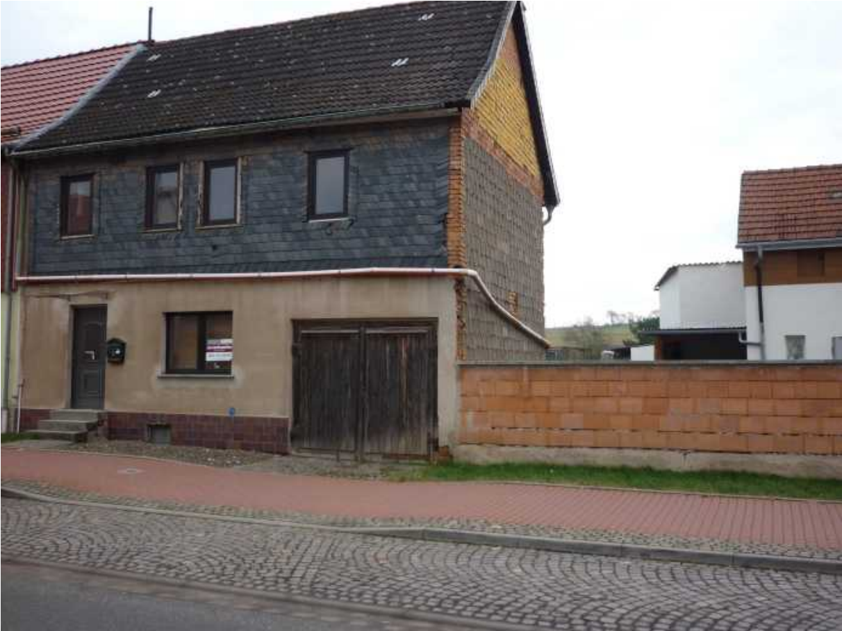
Nr. 11 – Ilfelder Straße 49
