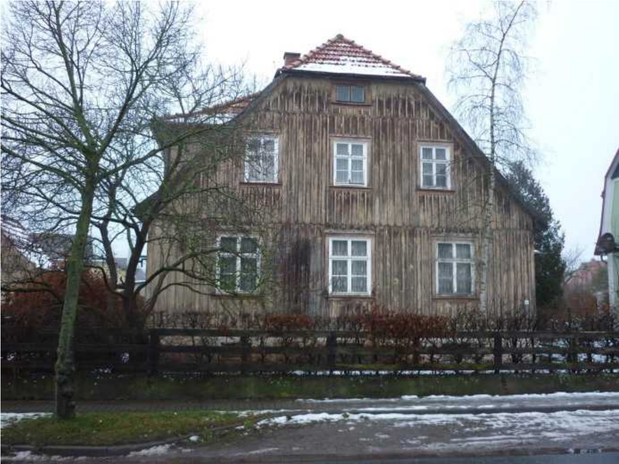
Nr. 21 – Nordhäuser Straße 15b
