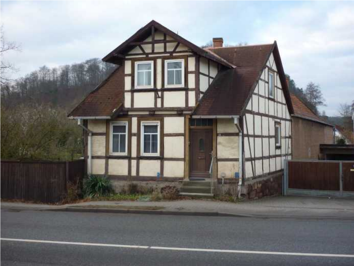
Nr. 8 – Ilfelder Straße 33
