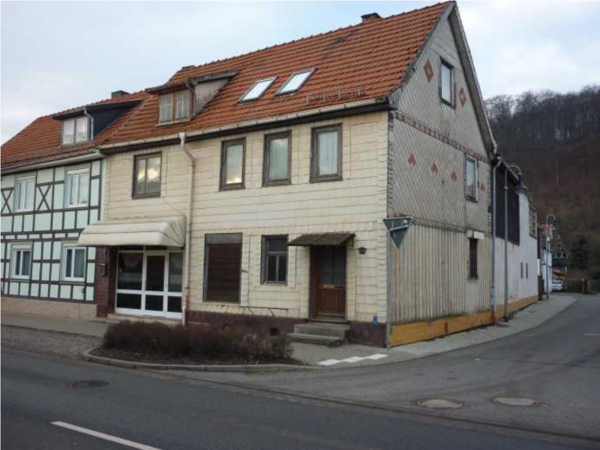
Nr. 9 – Ilfelder Straße 25
