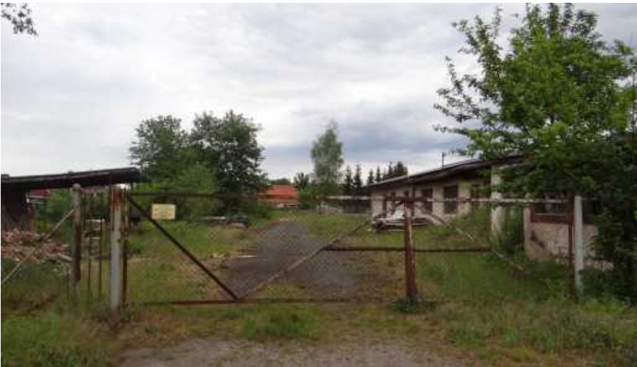
Bauliche Brache der ehemaligen gewerblichen Nutzung westlich des Bommelweges, Foto 2016
