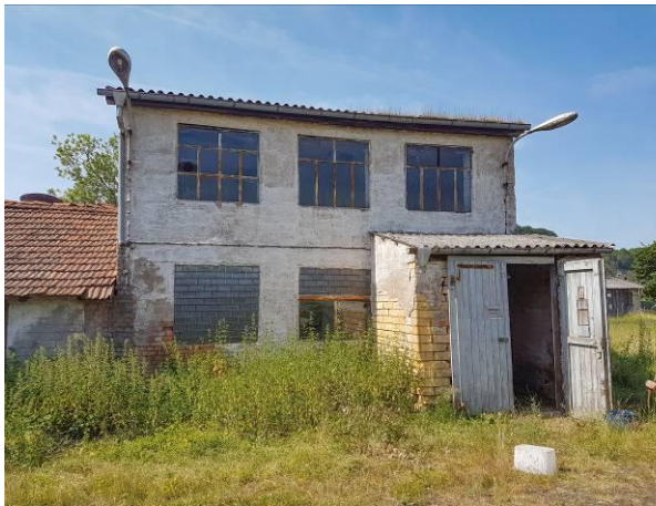
Abb. 5: Außenansicht des Schafstalls
