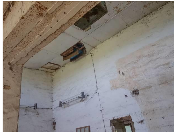
Abb. 6: Innenansicht des Schafstalls mit potentiellen Habitaten für Vögel, oder Fledermäuse
