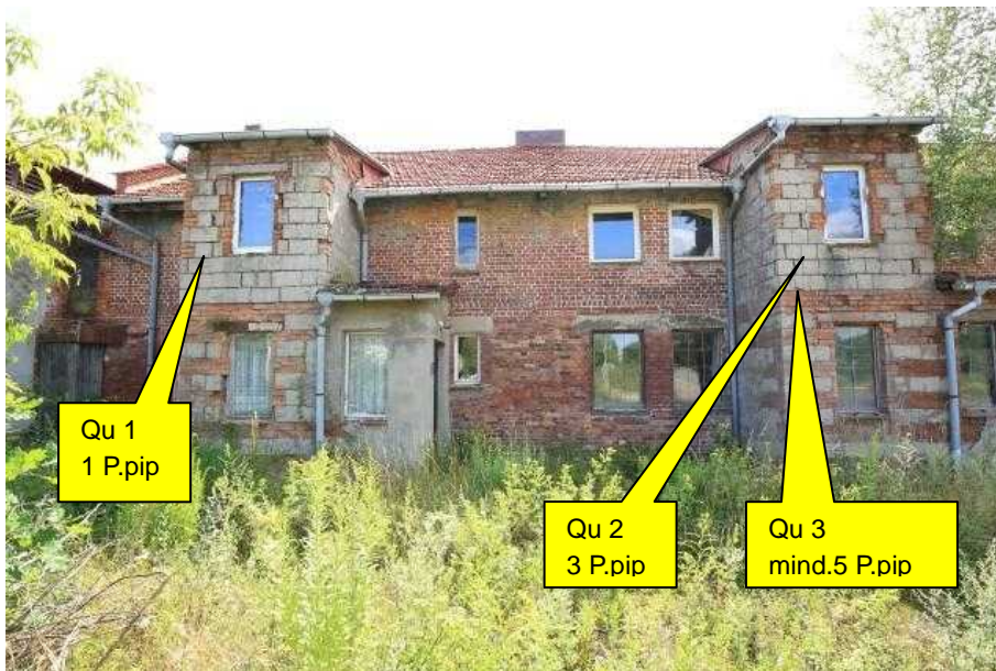
Abb. 10: Fledermausquartiere an der Nordwestfassade
