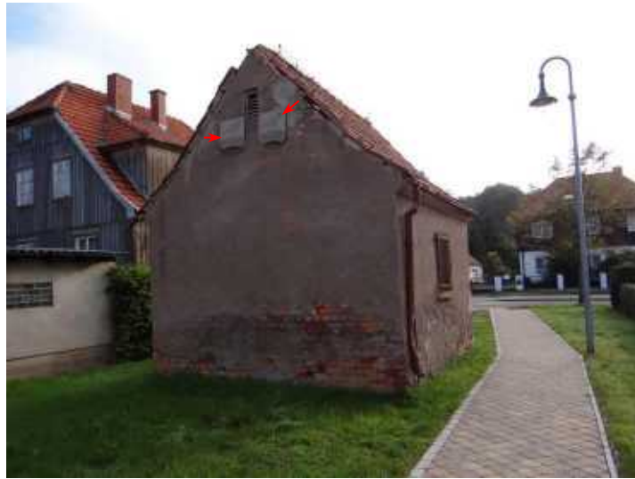
Abb. A 2: Installieren von Fassaden-Flachkästen an der Westseite des Gebäudes in der empfohlenen Höhe (Fotomontage)
