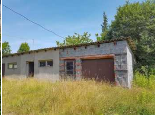
Abb. 9: Garagenreihe nordöstlich des Abrissgebäudes)
