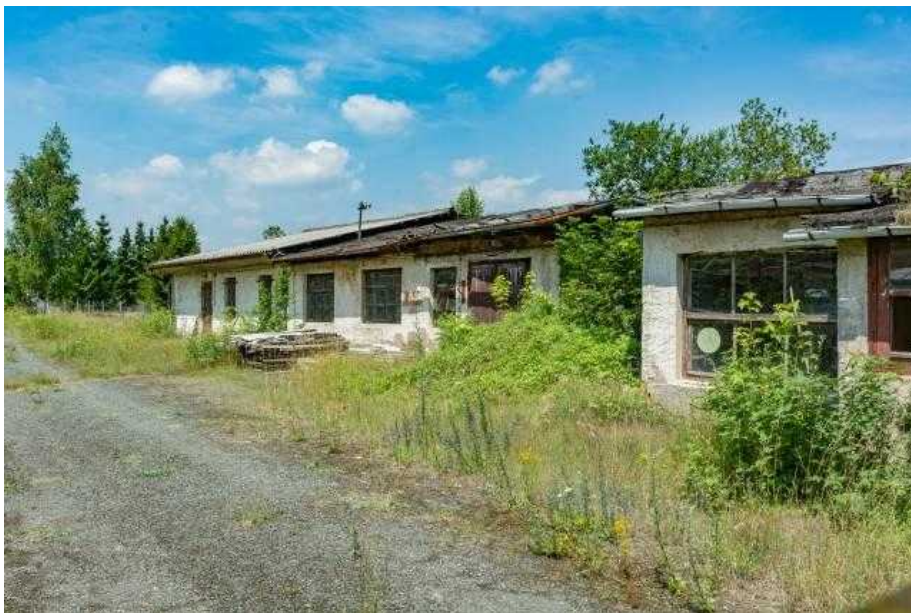
Abb. 2: Zum Teil eingestürzte Werksgebäude
