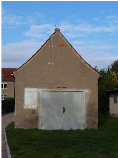
Abb. A 1: Verschließen des Fenster auf der Ostseite der alten Trafostation (Fotomontage)
