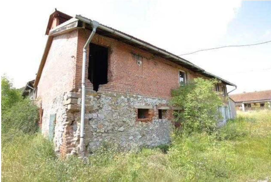
Abb. 5: Stallgebäude Ansicht Nordost
